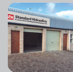
Sudáfrica (Port Elizabeth) Superficie 220 m2 Facilities / Installations
